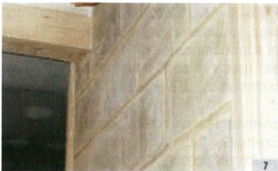
Mur en briques de terre crue
